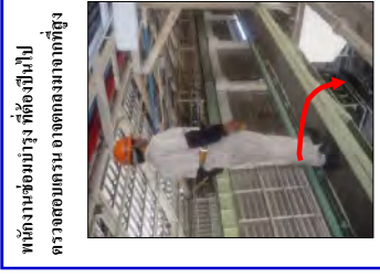
ผู้รับเหมาก่อสร้างต้องปีนเชือกที่สูง แต่ไม่ติด Safety Harness
